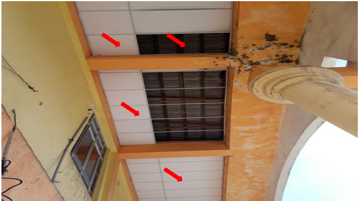
Kerja-kerja penggantian siling
