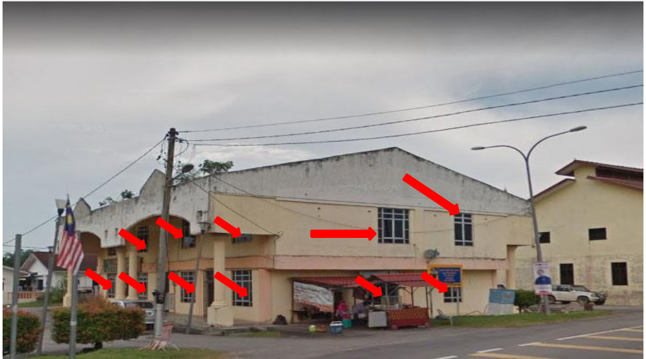
Kerja-kerja Pemasangan Grill pada bahagian tingkap
