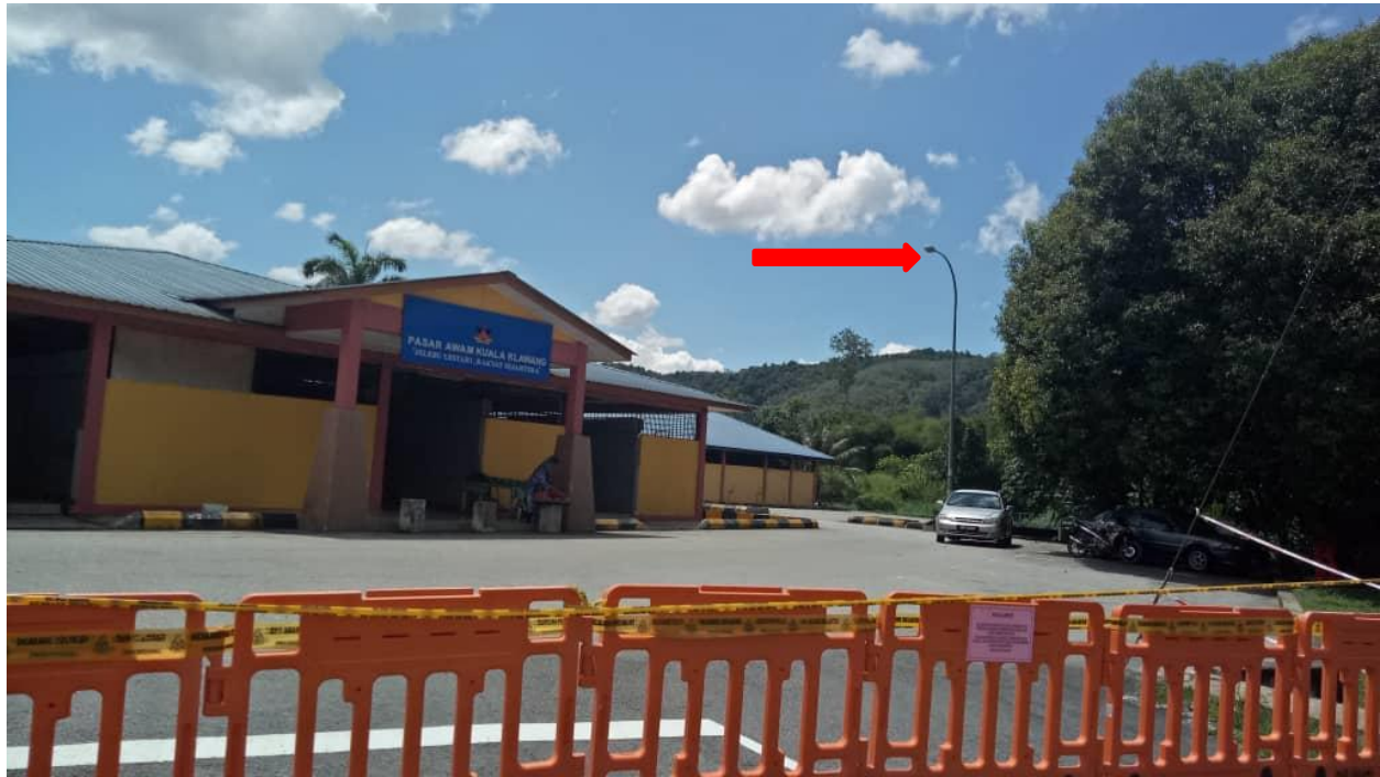
Kerja kerja Menukar lampu Jalan dari Jenis Son Ke Lampu Jalan Jenis LED Dan Kerja-Kerja Pendawaian Elektrik Dalam Tiang Galvanised
