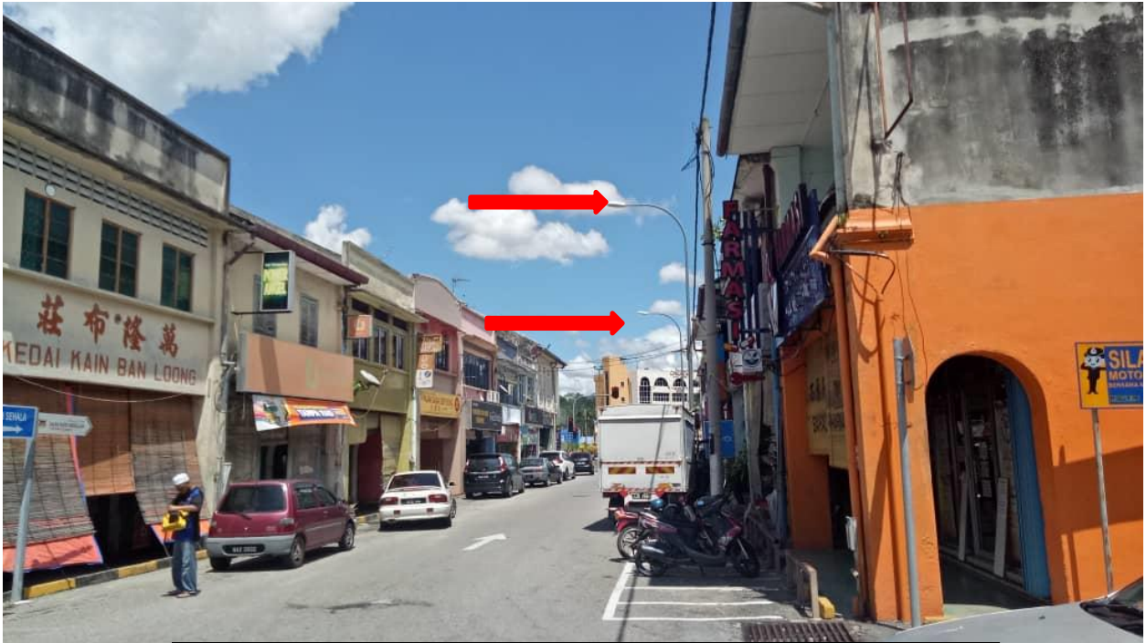
Kerja kerja Menukar lampu Jalan dari Jenis Son Ke Lampu Jalan Jenis LED Dan Kerja-Kerja Pendawaian Elektrik Dalam Tiang Galvanised
